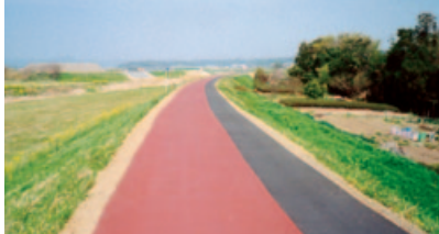
▲ カラー舗装用着色バインダー「CSファルト」施工事例
