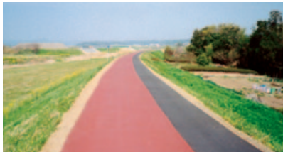
▲ カラー舗装用着色バインダー「CSファルト」施工事例
