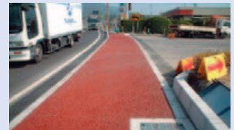
▲ 製品施工事例：当社大竹事業所前歩道
