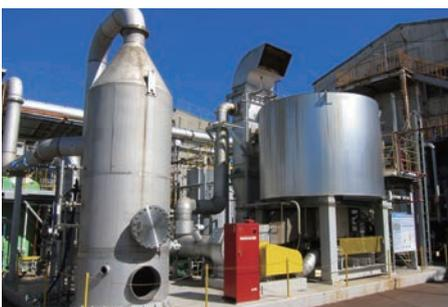
淀川工場の脱臭炉。PRTRの大気への排出量の抑制に寄与しています。
