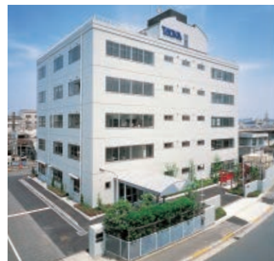
事務研究棟(研究施設強化に向け改装中)
