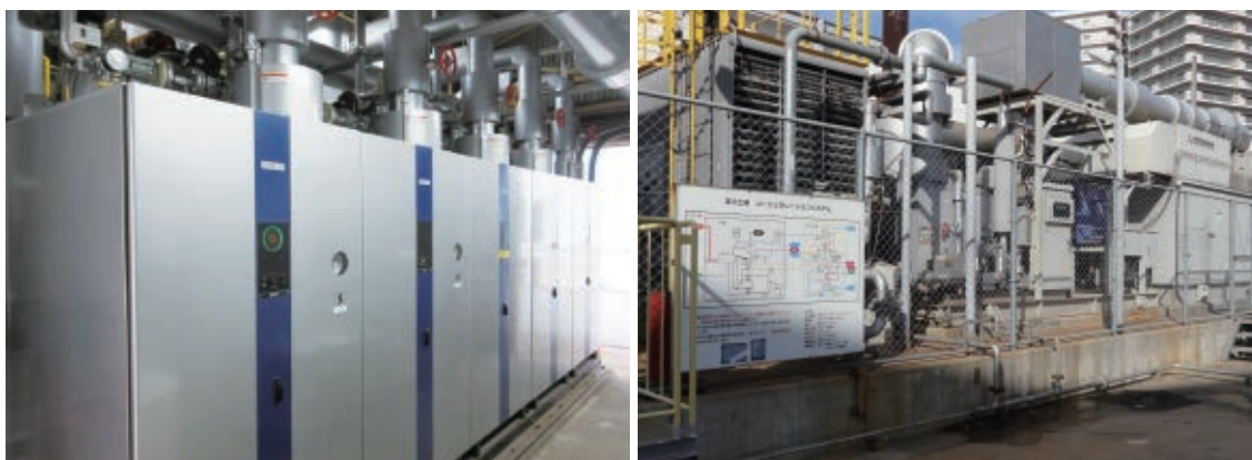
高効率設備に更新された淀川工場の蒸気ボイラー(左)とコージェネレーションシステム(右)。大気汚染物質の排出も適切に管理しています。
