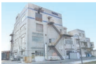
製造設備（田岡（天津）有機化学有限公司）
