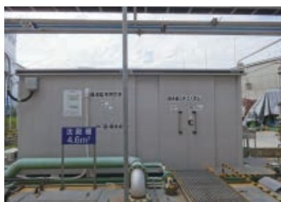
環境監視測定室
