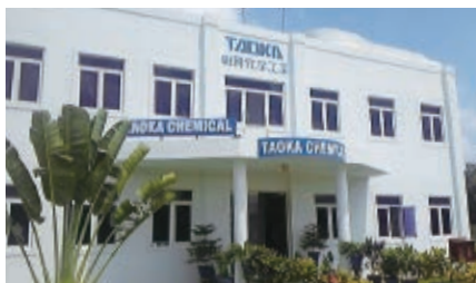
タオカケミカル インド工場事務所
