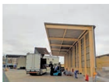
I-6倉庫西荷捌き場
