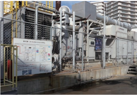
コージェネレーションシステム。大気汚染物質の排出も適切に管理しています。
