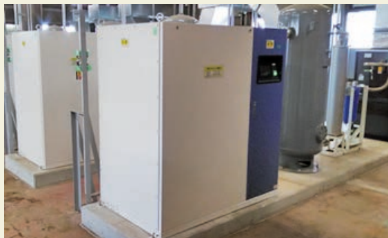
淀川工場 高効率窒素発生装置
