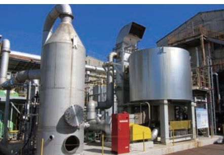
淀川工場の脱臭炉。PRTRの大気への排出量の抑制に寄与しています。
