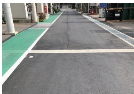
転倒防止対策を目的に整備された構内道路と側溝
