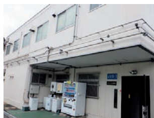
田岡淀川ジェネラルサービス株式会社事務所
