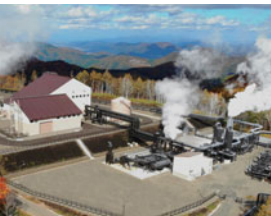
山葵沢地熱発電所
