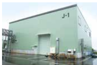
郡山工場の新純水棟
