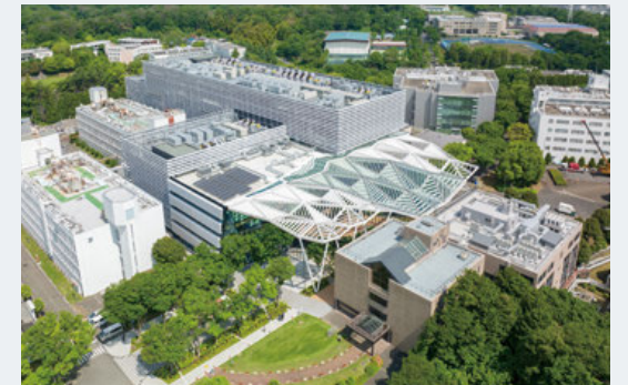
Science & Innovation Centerに新研究棟を開設
