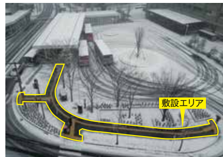
「エスロヒート下水熱(管底設置型)」による融雪状況
