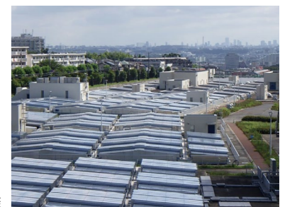
浄水場に設置されたアルミ覆蓋
