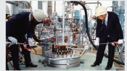
1984年 石炭ガス化プラント火入れ式
