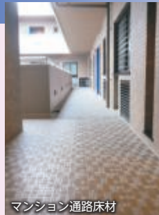
マンション通路床材
