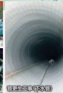
管更生工事(下水管)
