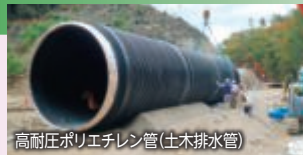
高耐圧ポリエチレン管(土壌排水管)
