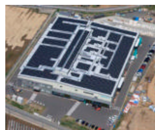
タキロンポリマーの太陽光パネル
