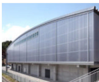
ポリカーボネート樹脂製高断熱中空パネル「ルメウォール」施工例
