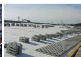
河川護岸（シート）
