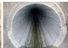
更生後下水道管
