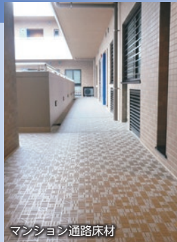
マンション通路床材
