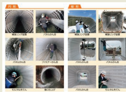
管更生工法 施工事例
