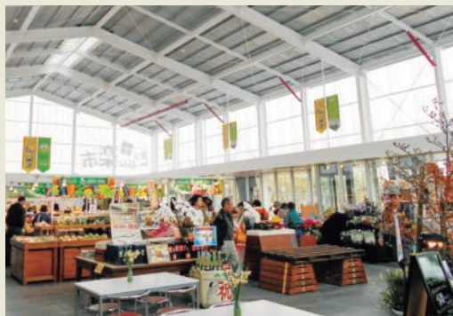
複層ポリカーボネートパネル施工例
