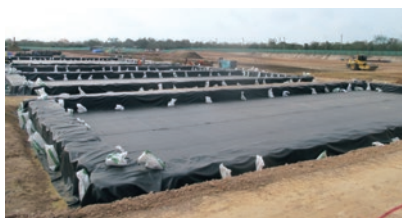
藻の培養池用シート施工(タイ)
