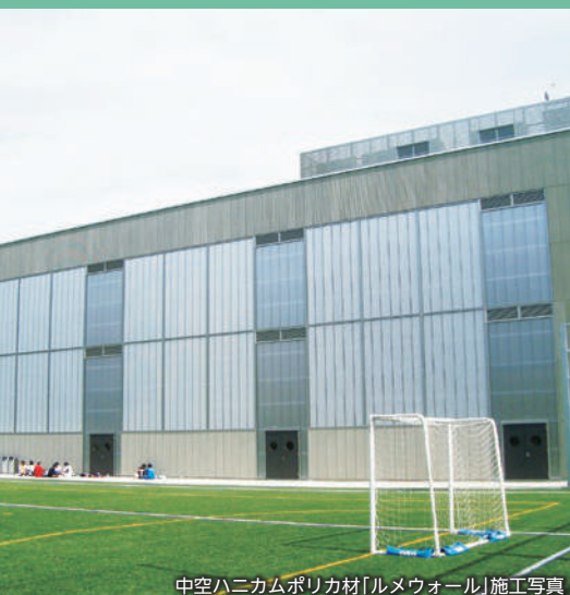
中空ハニカムポリカ材「ルメウォール」施工写真
