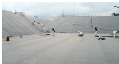
ため池用シート施工
