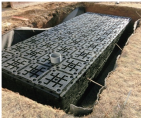
雨水貯留浸透槽「レインセーブN」施工写真
