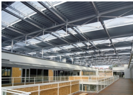
ポリカ折板施工写真(天井部分)
