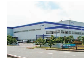
6 中関第1工場 山口県防府市浜方534-7
