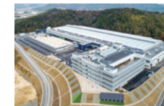
① 本社 / 本社工場 広島県東広島市寺家 産業団地5番1号
