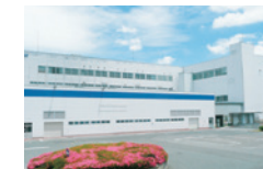
② 八本松工場 広島県東広島市八本松町原 175-1
