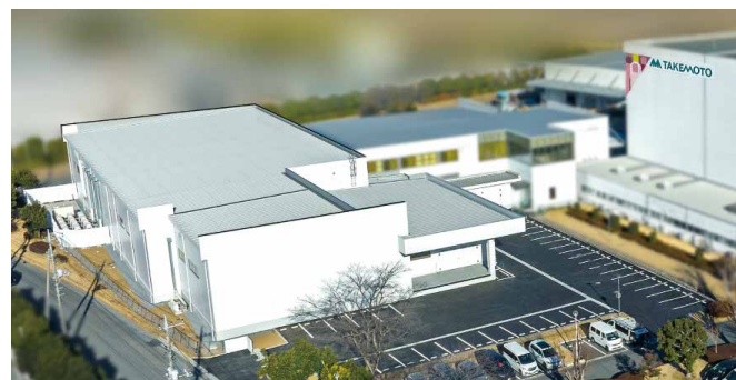
新ブロー棟外観
