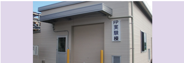
鹿島工場のフロー合成のパイロットプラント
