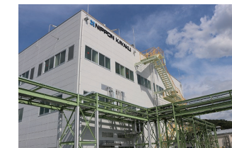
新規マレイミド樹脂の 製造設備（厚狭工場）
