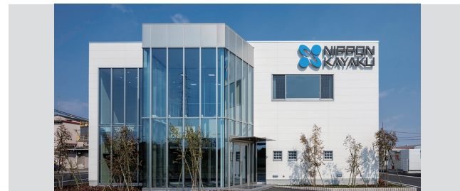
福山工場の品質管理棟
