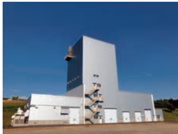
推進薬パイロットプラント
