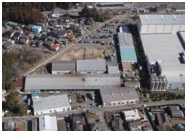
石岡工場の全景
