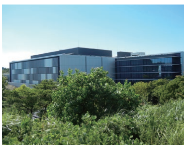
高度な環境性能を誇る 東京第一データセンター
