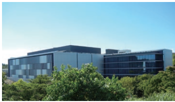
東京第一データセンター
