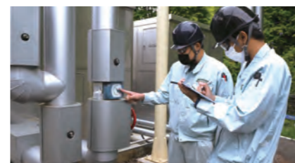
設備点検は継続的生産に欠かせない作業です。
