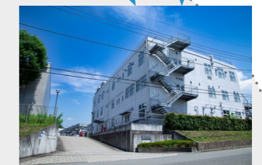
上野原第二工場 特徴：1トンから10トンの高純度化学薬品を製造するケミカルプラントを有する工場
