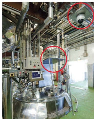
原料投入口にカバーとモニタリングカメラを設置
