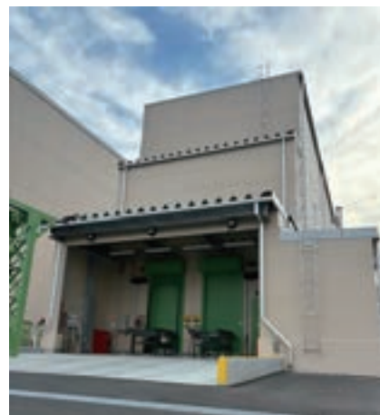
2024年6月に完工した 千葉工場・危険物格納冷蔵自動倉庫
