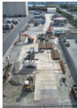
始まった新電材プラント建設工事の様子
