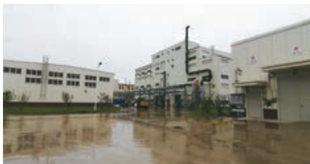
新たに完成した第2生産棟(中央)と危険物倉庫(左・丙類、右・甲類)
