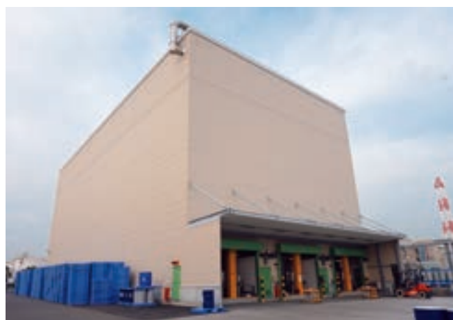
千葉工場危険物立体自動倉庫
