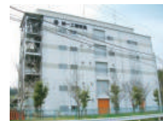
1970年 ショ糖脂肪酸エステル工場を建設
