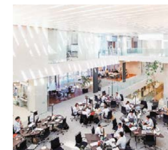
NIC4階からの内観 コンクリートの天井スリットが光・風の通り道として機能
