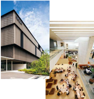
設計／小堀哲夫建築設計事務所 構造設計／ARUP 施工／清水建設株式会社
