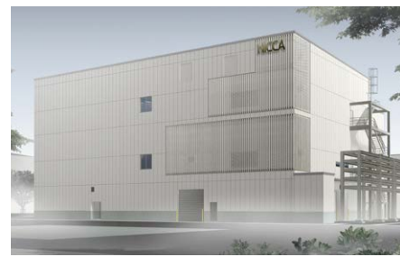
鹿島工場二期工事である第2工場完成予想図 2019年7月稼働開始予定
