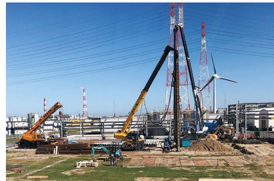
2019年下期での稼働開始を予定し、二期工事が進められている鹿島工場
