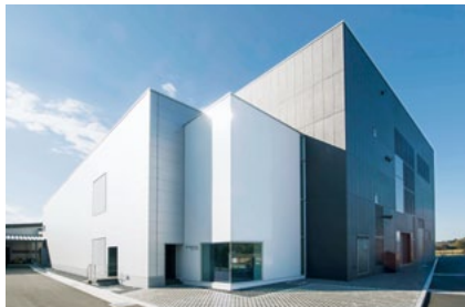
新工場棟の外観
