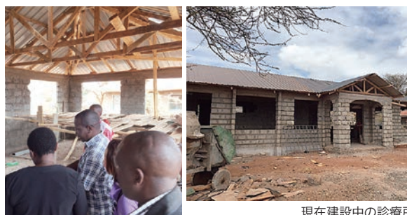
現在建設中の診療所
