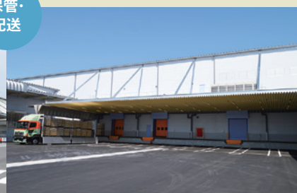
西日本物流センター(兵庫県小野市)
