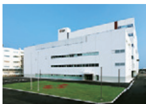
静岡工場事務QC棟
