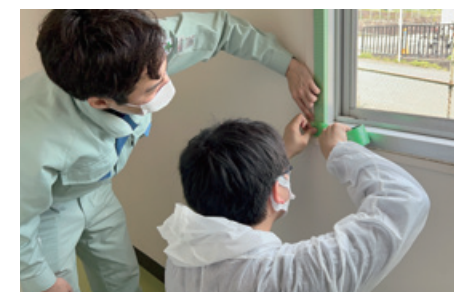
塗装しない箇所をテープで養生
