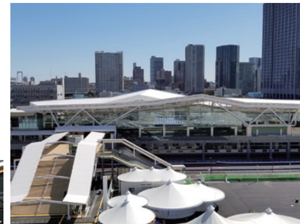
高輪ゲートウェイ駅舎全景
