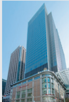
日本橋高島屋三井ビルディング
