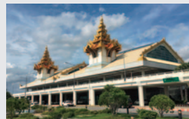
マンダレー国際空港ターミナルビル
