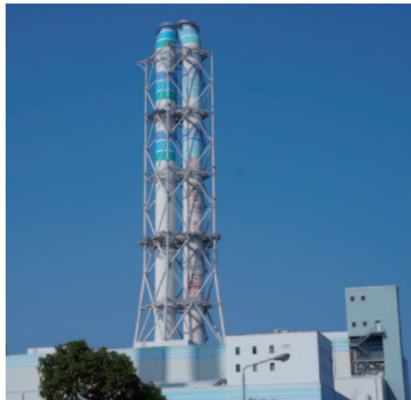
九州電力(株)新大分発電所(煙突)▶
