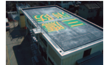
◀三鷹消防署ヘリサイン
