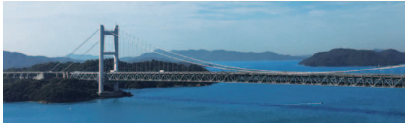
▲下津井瀬戸大橋
