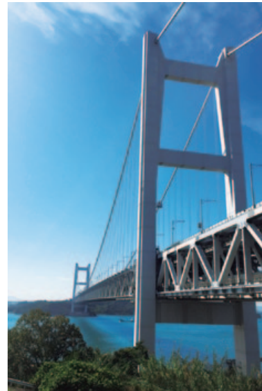
▲下津井瀬戸大橋
