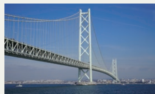
明石海峡大橋 (本州四国連絡高速道路㈱提供) 当社のふっ素樹脂塗料[Vフロン#100H]が採用され、1998年の完成以来、長きにわたって橋を護り続けています。
