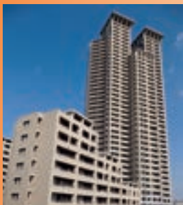
▲ ニットクメンテ(株)による マンション改修工事
