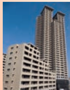
▲ニットクメンテ(株)によるマンション改修工事
