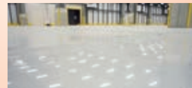
▲塗り床材「ユータックE-30N」 (ヤマト運輸(株)関西ゲートウェイターミナル)
