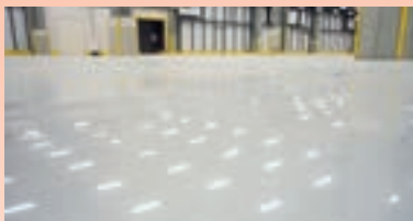
▲塗り床材「ユータックE-30N」 (ヤマト運輸(株)関西ゲートウェイターミナル)
