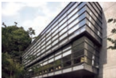
▲FRP屋根用防水材「タフシール防水工法」 （坂の上の雲ミュージアム）
