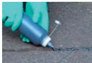
▲ひび割れに補修材を注入
