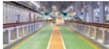
塗り床材「ユータックE-40」(北海道新幹線函館総合車両基地)
